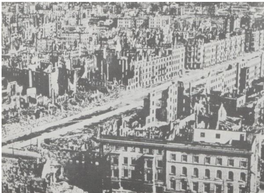
Dresde en 1945, un claro símbolo de la destrucción de Europa en la posguerra.
