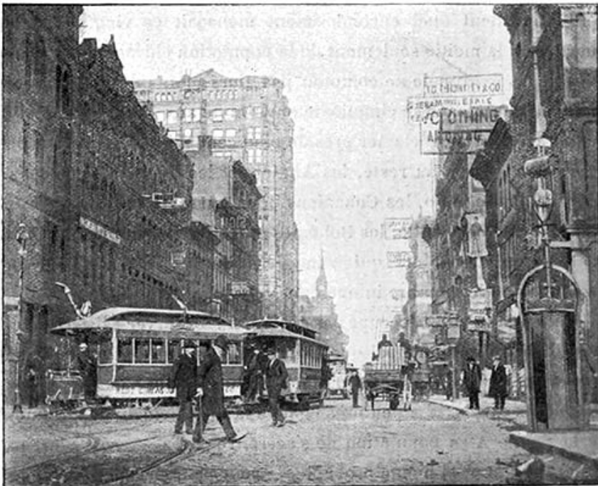
Chicago - Madison Street, esquina con la Quinta Avenida
