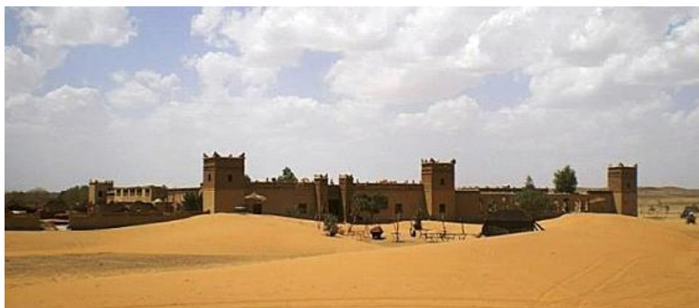
La antigua fortaleza de Erg Chebbi, en la ruta de las caravanas, hoy un hotel aislado en medio de las dunas del desierto del Sahara. Todavía,
